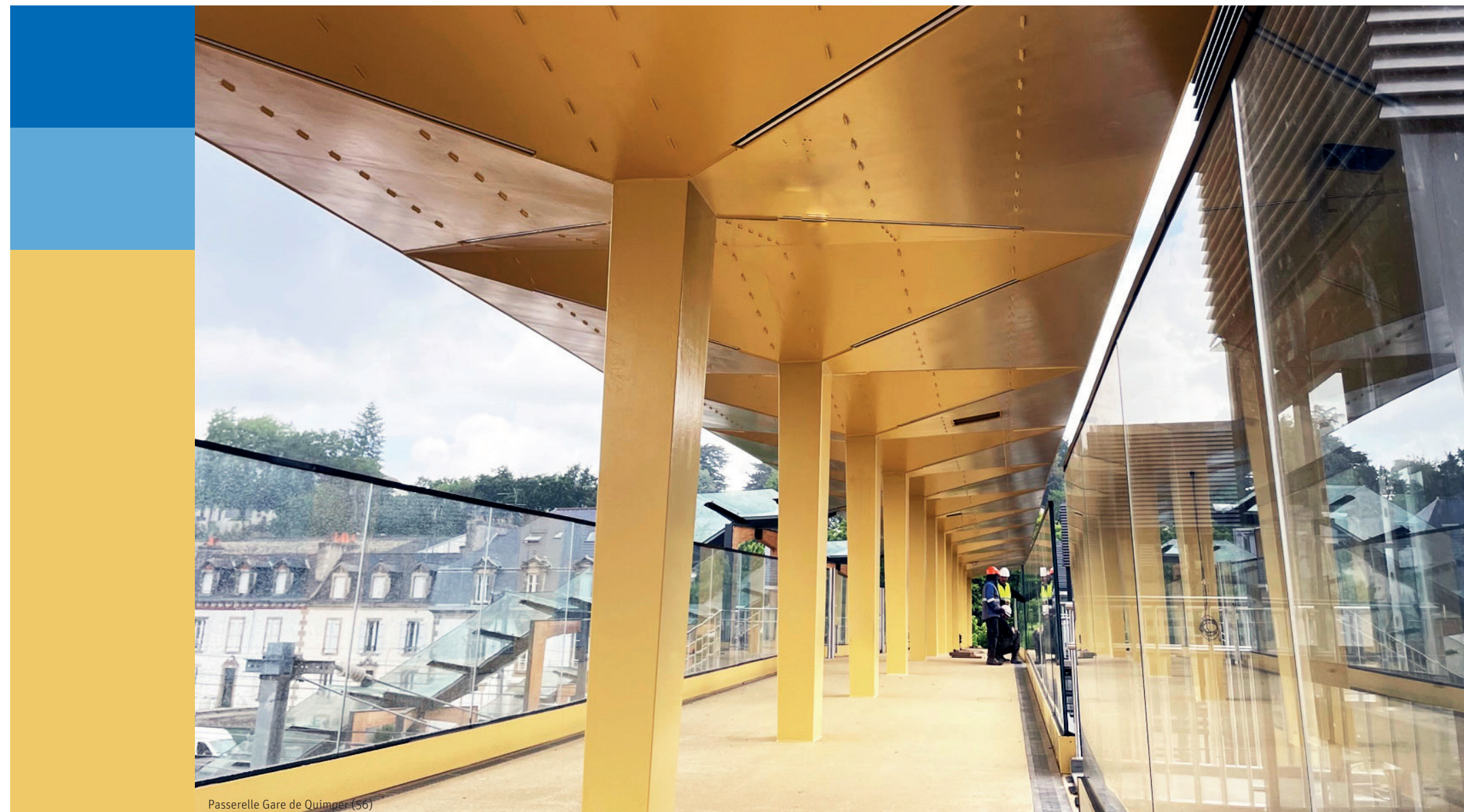
Passerelle Gare de Quimper (56)
